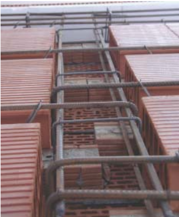
Spojovacia výstuž nad vnútornou nosnou stenou
