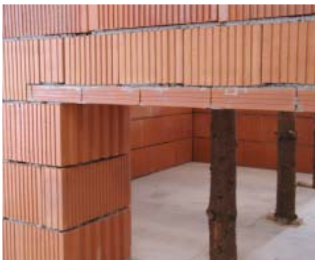
Pohľad na hotový preklad s použitím KPP s murovanou tlakovou zónou
