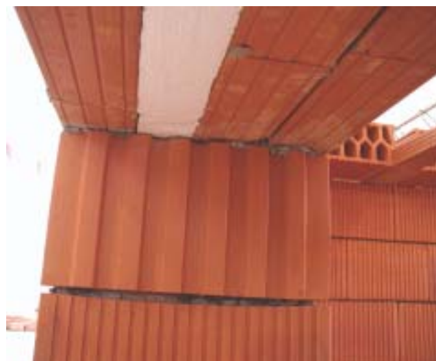
Pohľad zospodu na skladbu prekladu so zabudovanou tepelnou izoláciou
