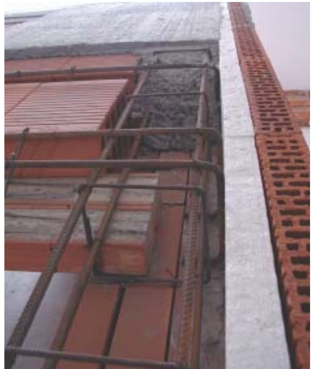
Spojovacia výstuž nad obvodovou stenou
